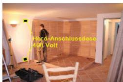
Mögliche, **aber unschön wirkende**, Variante der Kabelverlegung. Die Anschlussdose befindet im sichtbaren Bereich neben oder über der Saunakabine. Der Kabelverlauf bleibt so nach dem Saunaeinbau sichtbar.
